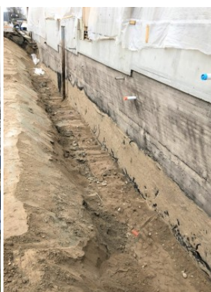
Sokkelirakenteiden saneerausta
